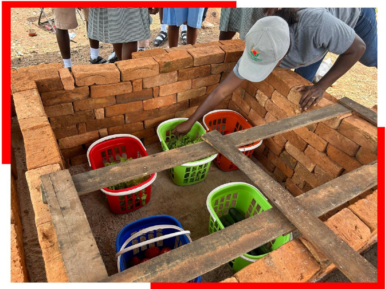
Figure 8 : Chambre de refroidissement à énergie zéro (ZECC)
